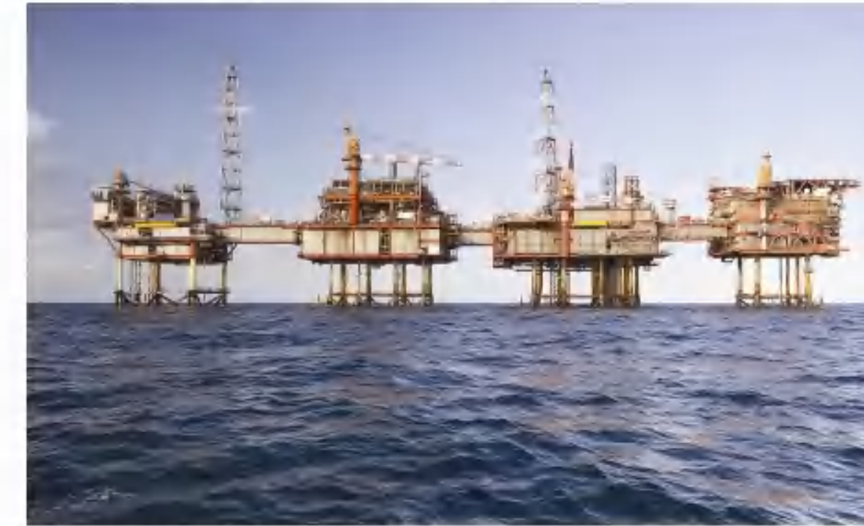
海洋工程 Oceanic Engineering
